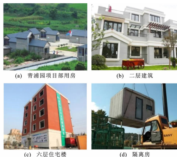
图 8 3D 打印居住建筑
